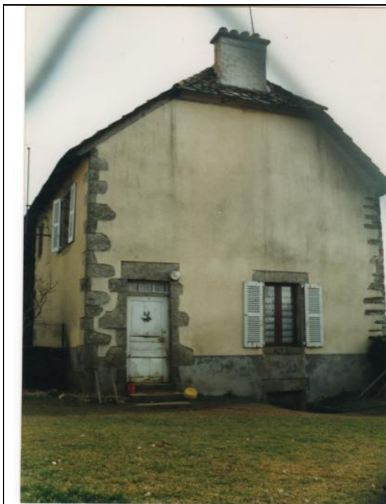
L'ancienne école de Trémoulines
