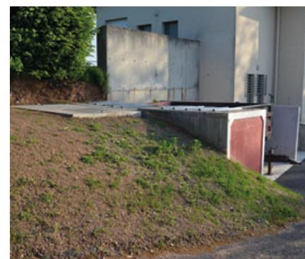
D'anciennes cuves à vin en béton ont également été achetées afin de stocker les eaux de pluie provenant de la toiture de ce hangar. Désormais, environ 20 m<sup>3</sup> d'eau peuvent être retenus et seront mis à disposition de tous les prunétois pour l'arrosage en période de restriction.
